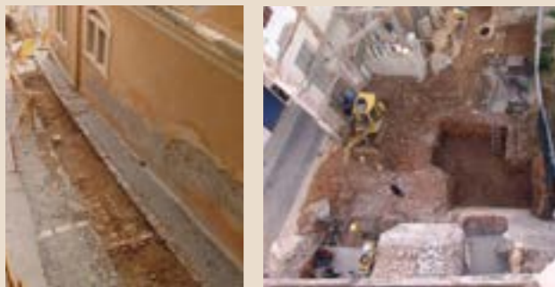
Excavacions al carrer Fonollar i al carrer Major.
