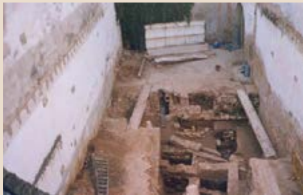
Excavacions a la Casa del Poble.
